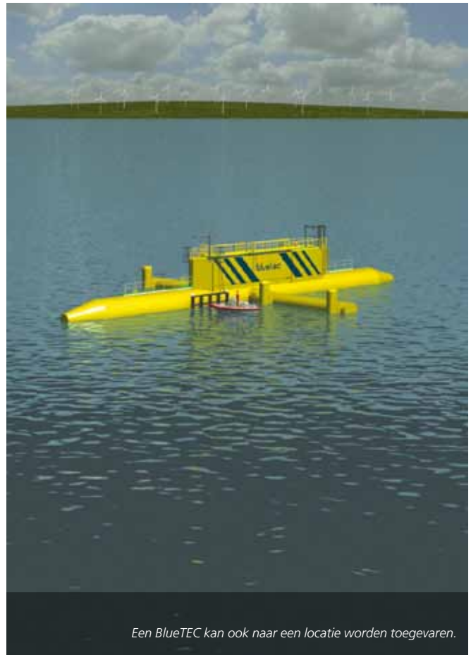
De getijdencentrale BlueTEC bestaat uit een stalen drijver van 60 meter lang met daarop een dekhuis en is in het totaal 30 meter breed.
